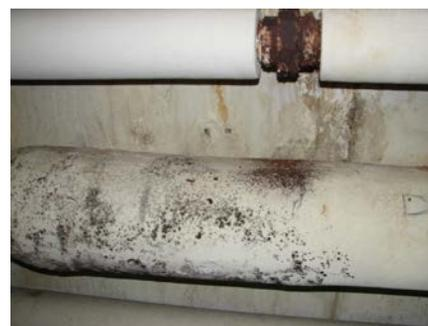
Prolifération fongique sur un tuyau recouvert d'amiante.
