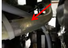
Figure 1 Présence de biofilm dans la tubulure
